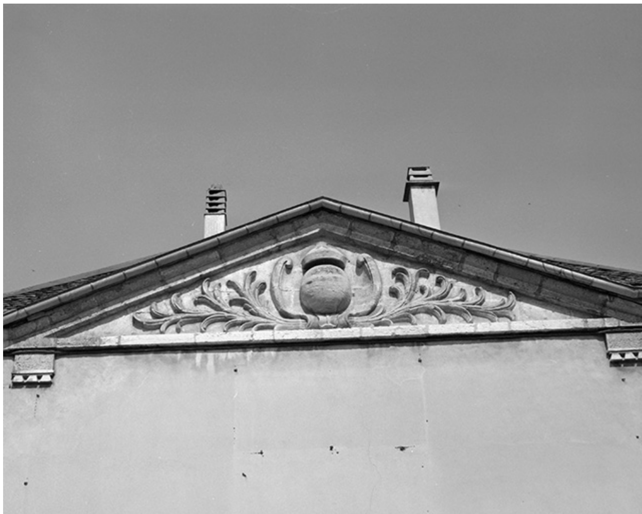
Fronton de pignon sur rue.
