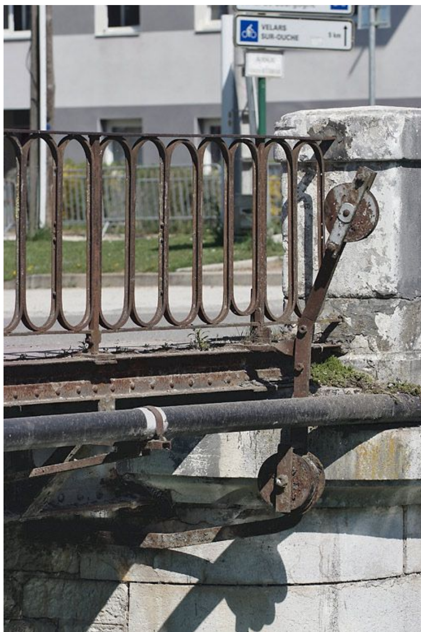
Détail du garde-corps et de la poulie.
