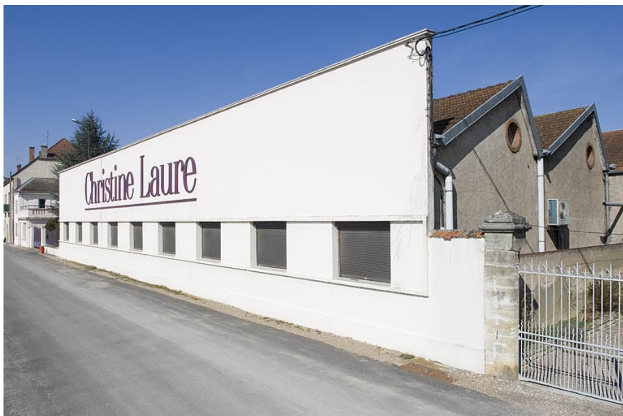
Façade sud de l'atelier de fabrication.
