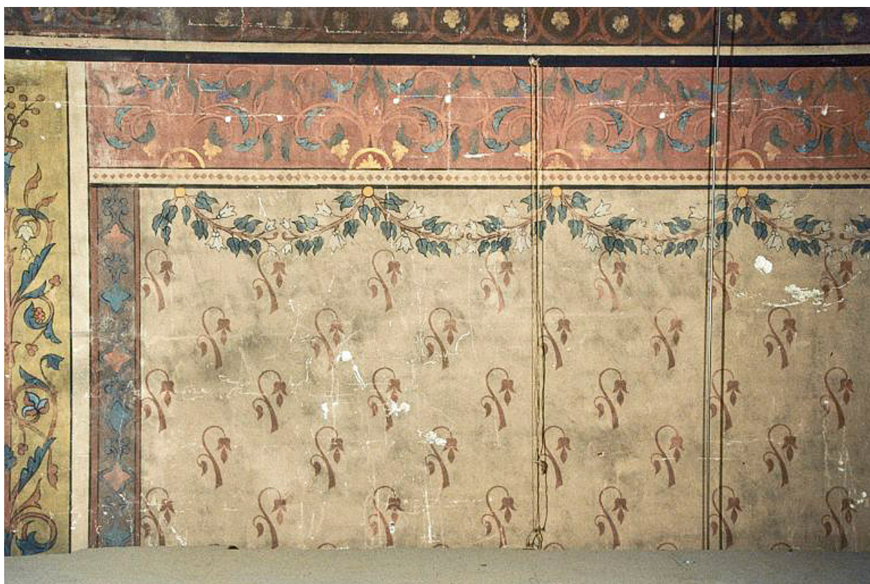
Nef, mur nord (1991) : peinture monumentale.
