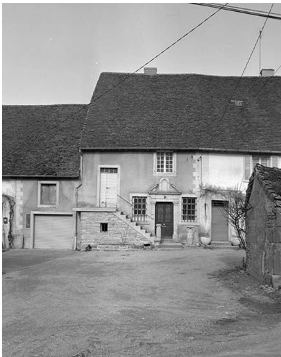
Maison située rue de Vallière.
