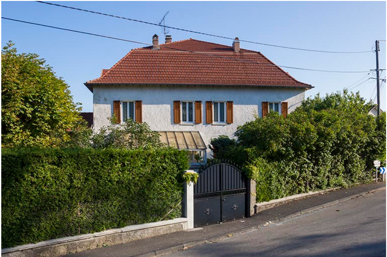
Logement : façade antérieure.
