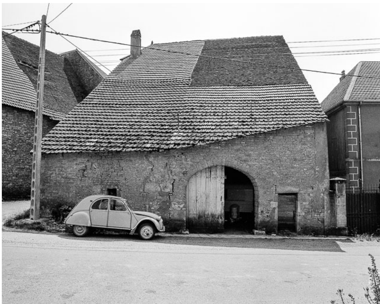
Façade latérale droite.
