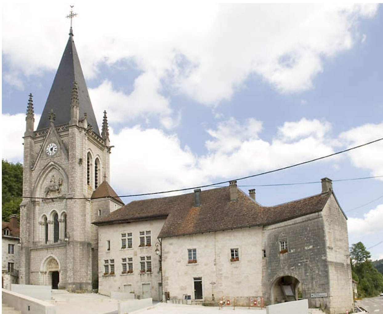
Vue d'ensemble des façades
