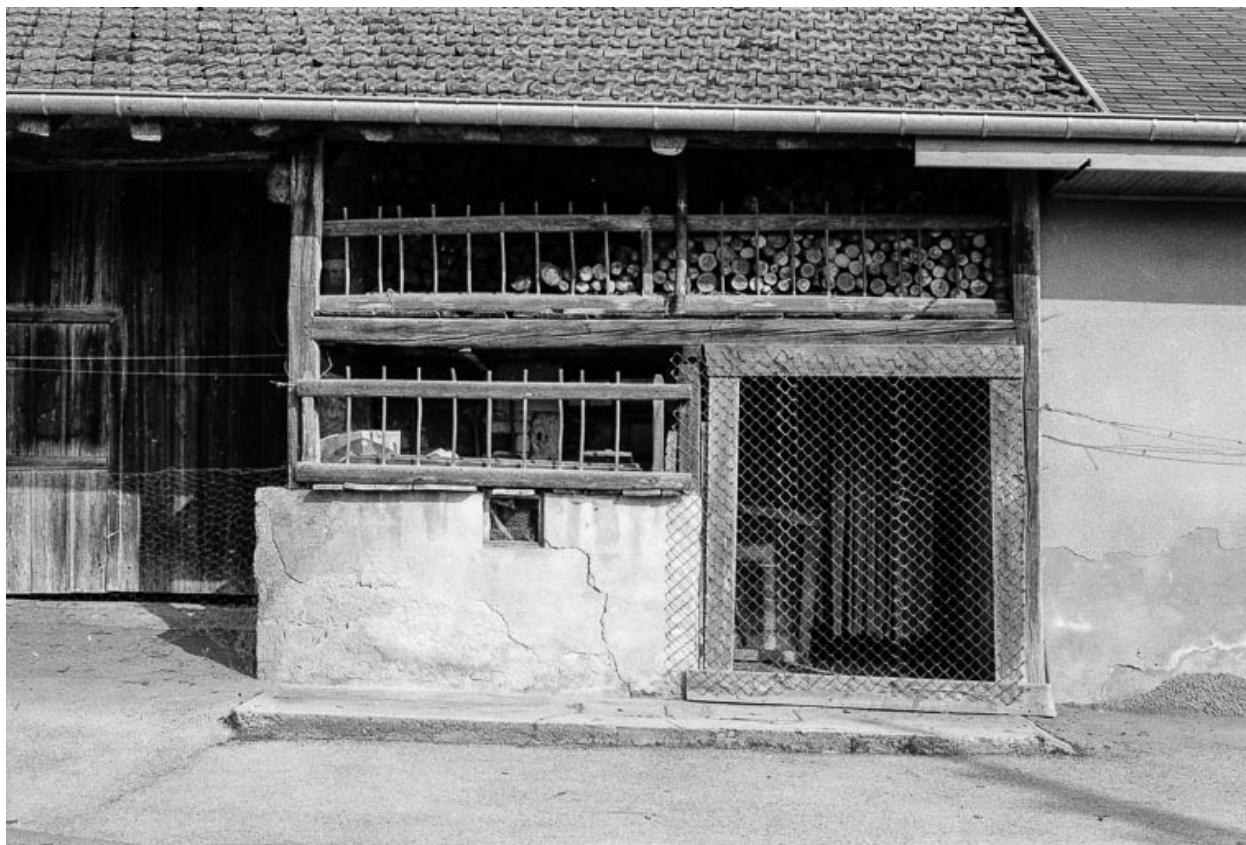
Ferme : détail de la façade antérieure.
