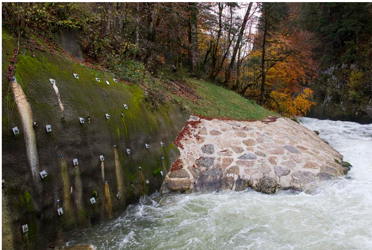
Berge renforcée en aval des vannes toit.
