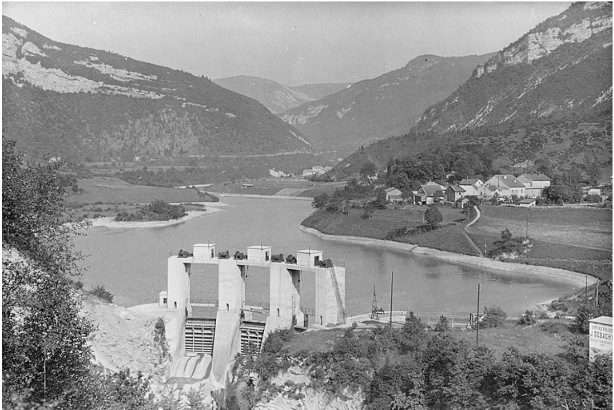
Barrage d'Etables et bassin de retenue.
