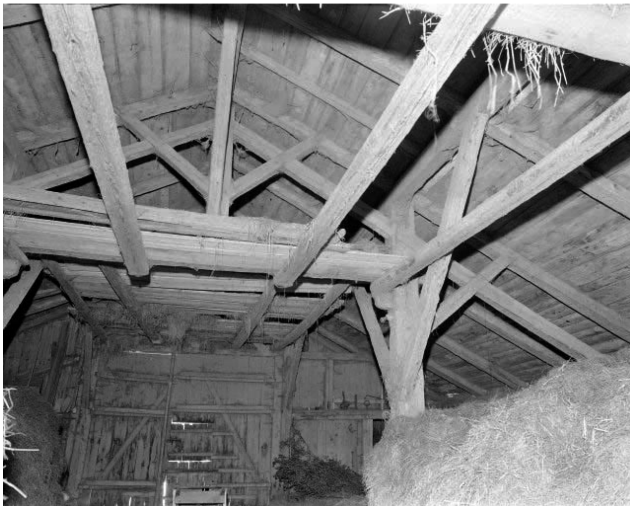
Intérieur : charpente du bâtiment annexe.
