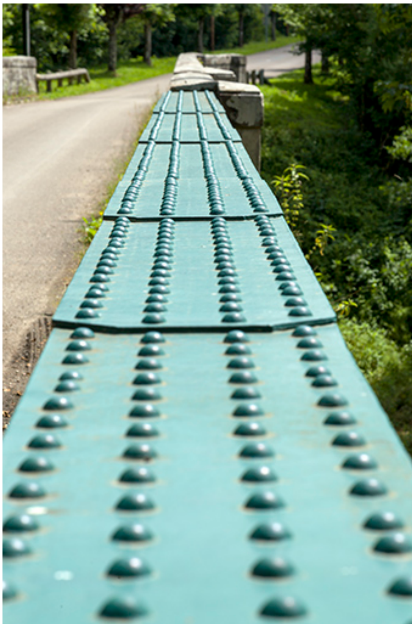
Détail de la rambarde de la passerelle.
