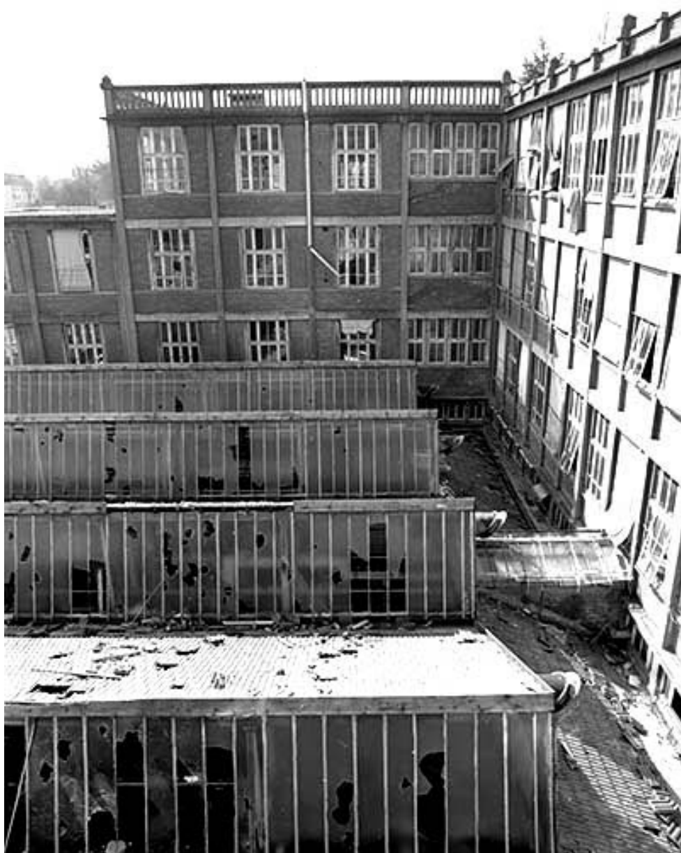
Bâtiment (2a) et sheds du bâtiment (3).
