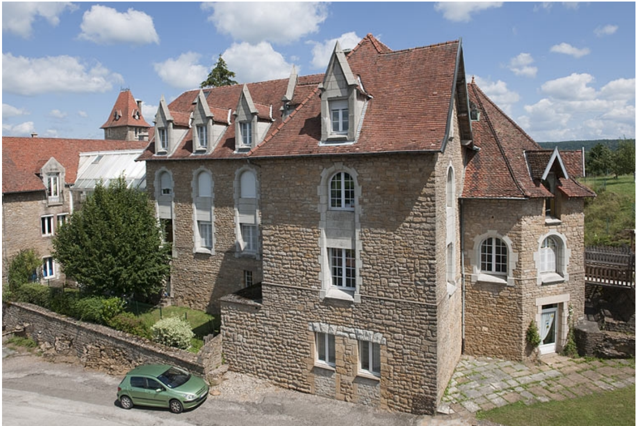
Bâtiment (G), vue d'ensemble côté rue.
