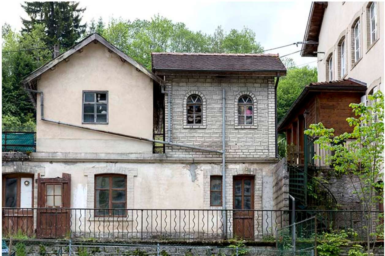
Atelier, garage et dépendance, depuis le nord.
