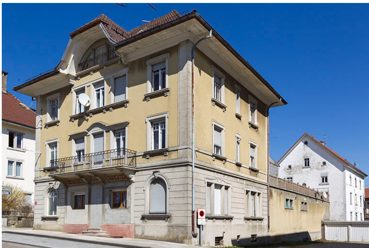
Façades antérieure et latérale droite.
