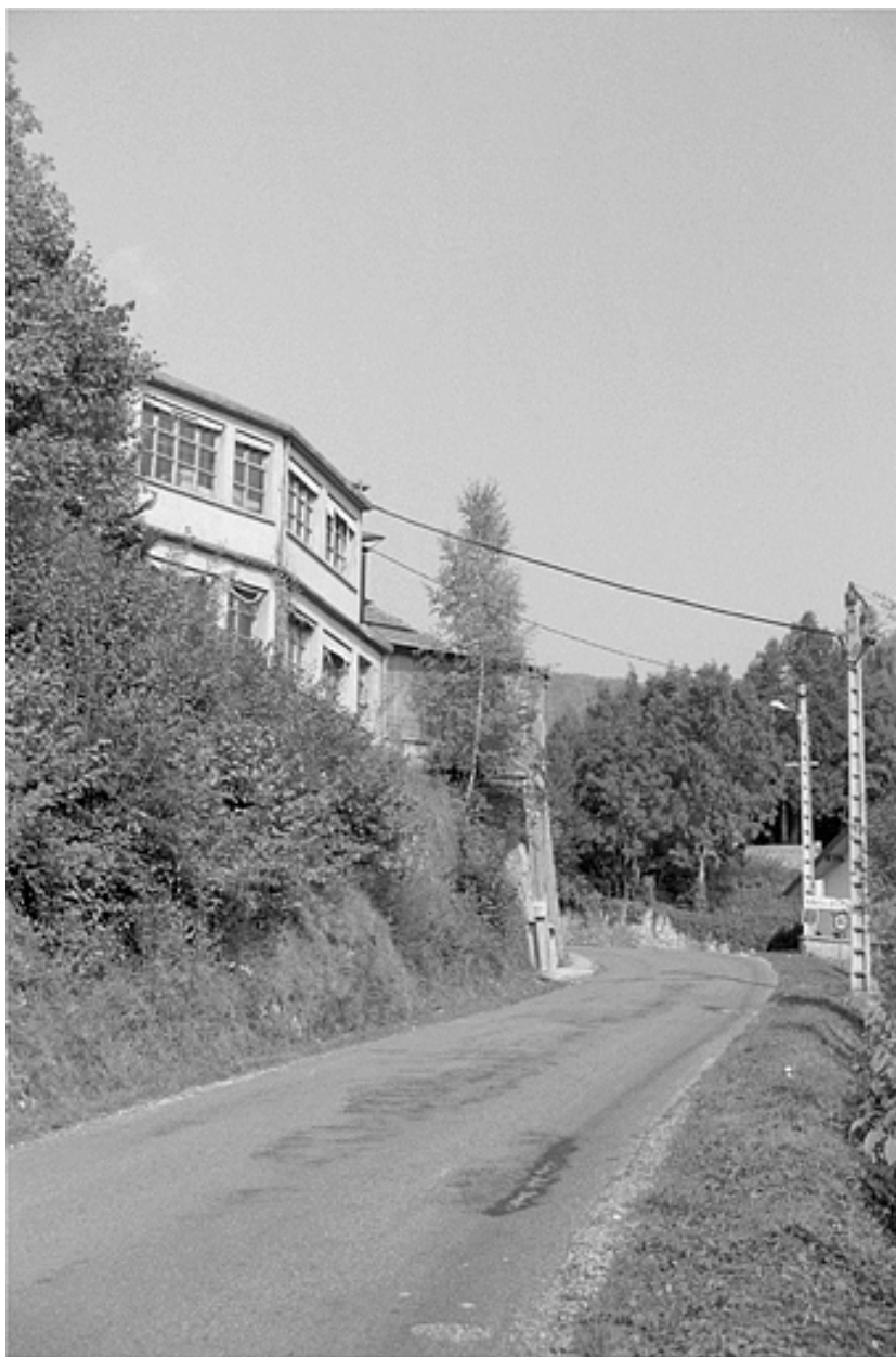
Façade latérale gauche.
