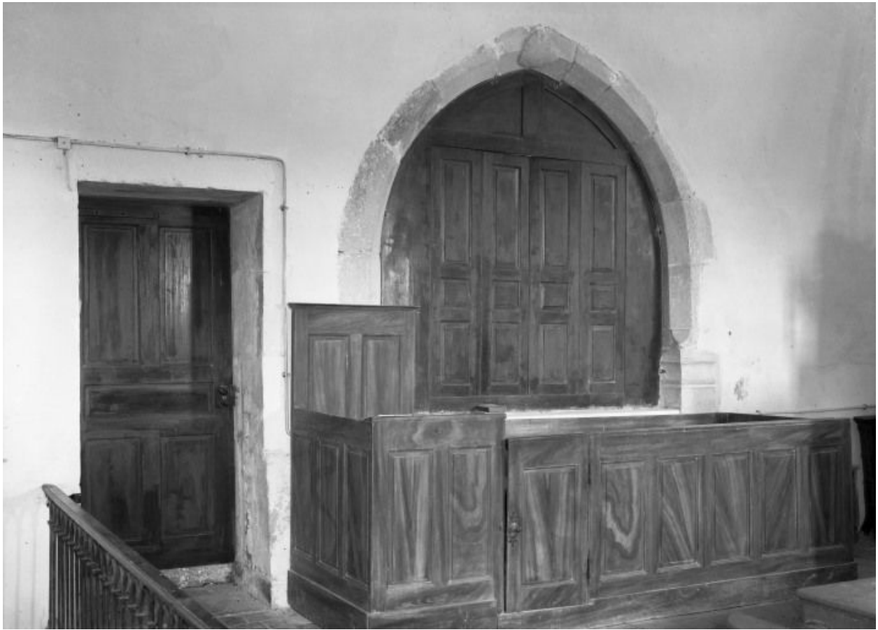
Choeur, mur gauche
