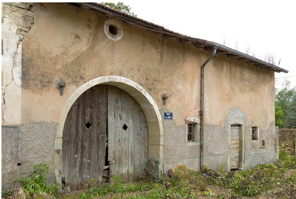
Vue sur la partie agricole.
