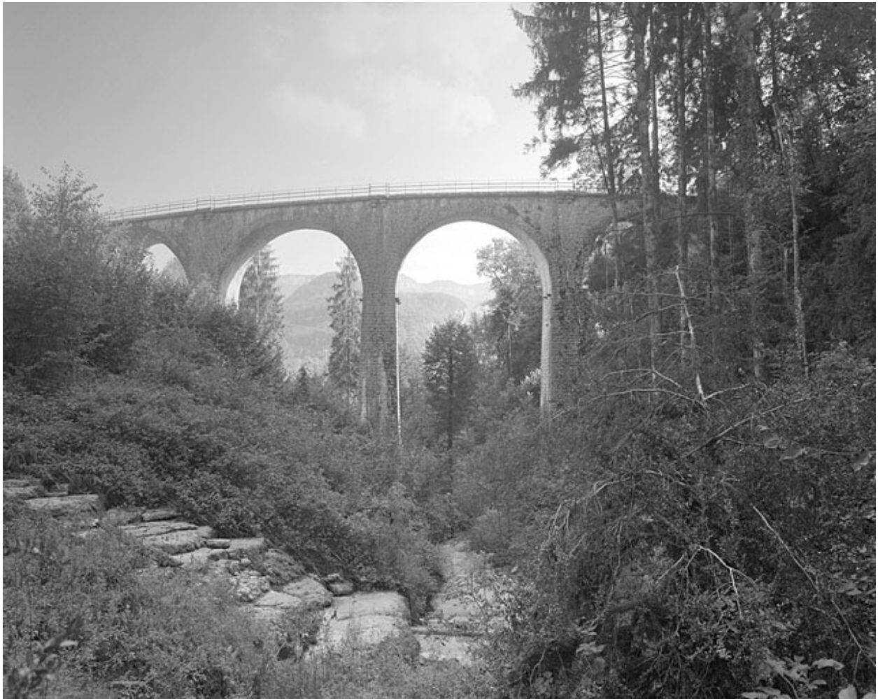
Le viaduc depuis le ruisseau du Nans.
