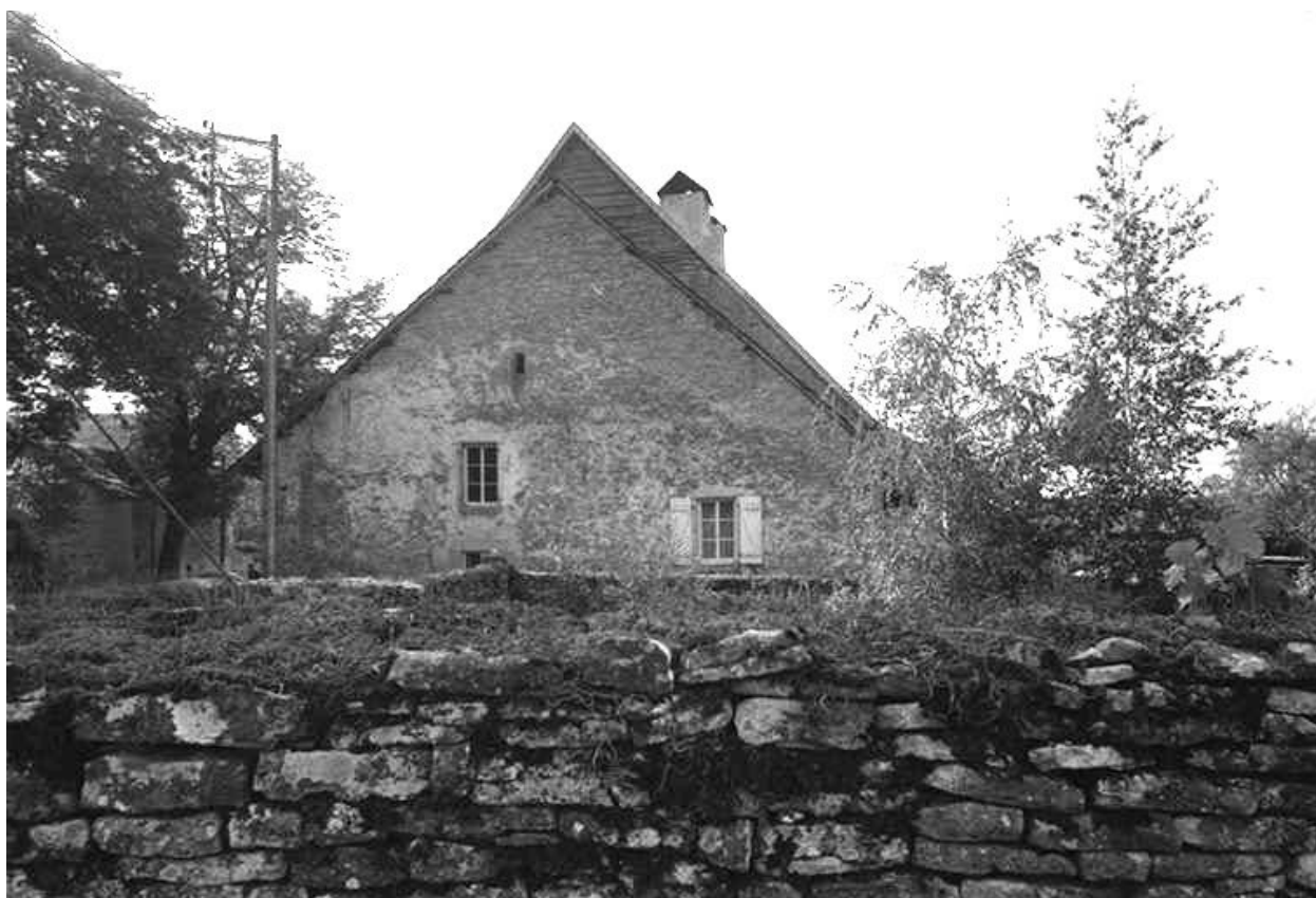
Façade latérale droite.
