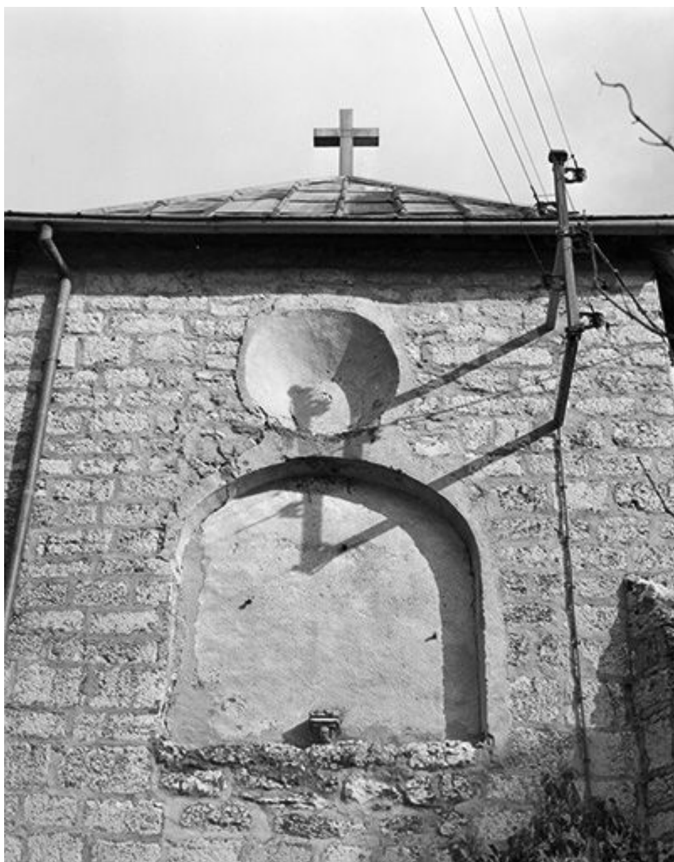
Baies murées du chevet.
