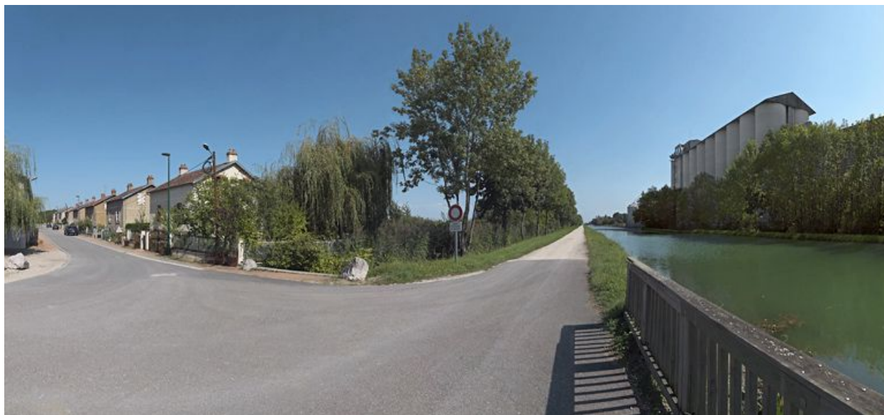
Détail des logements dépendants du site industriel.
