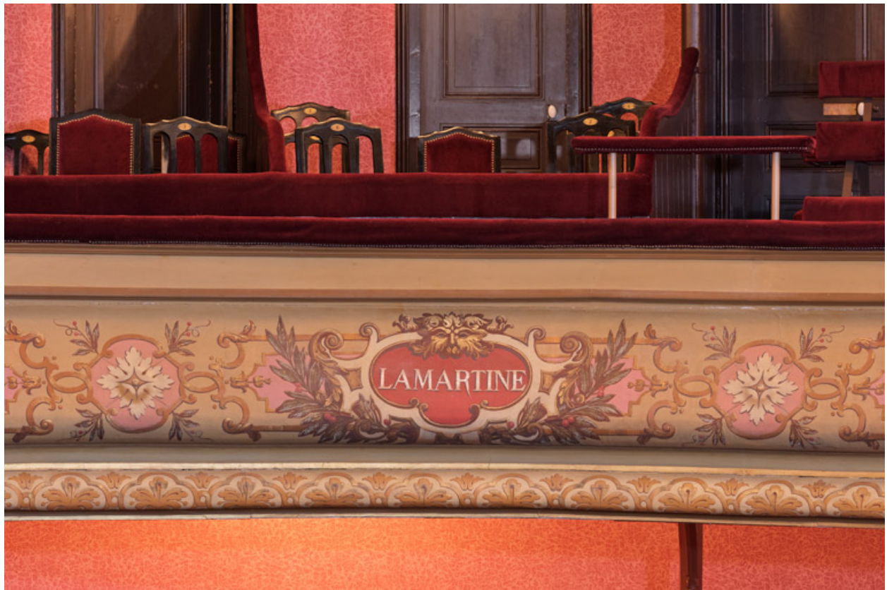
Garde-corps du 1er balcon (Lamartine).
