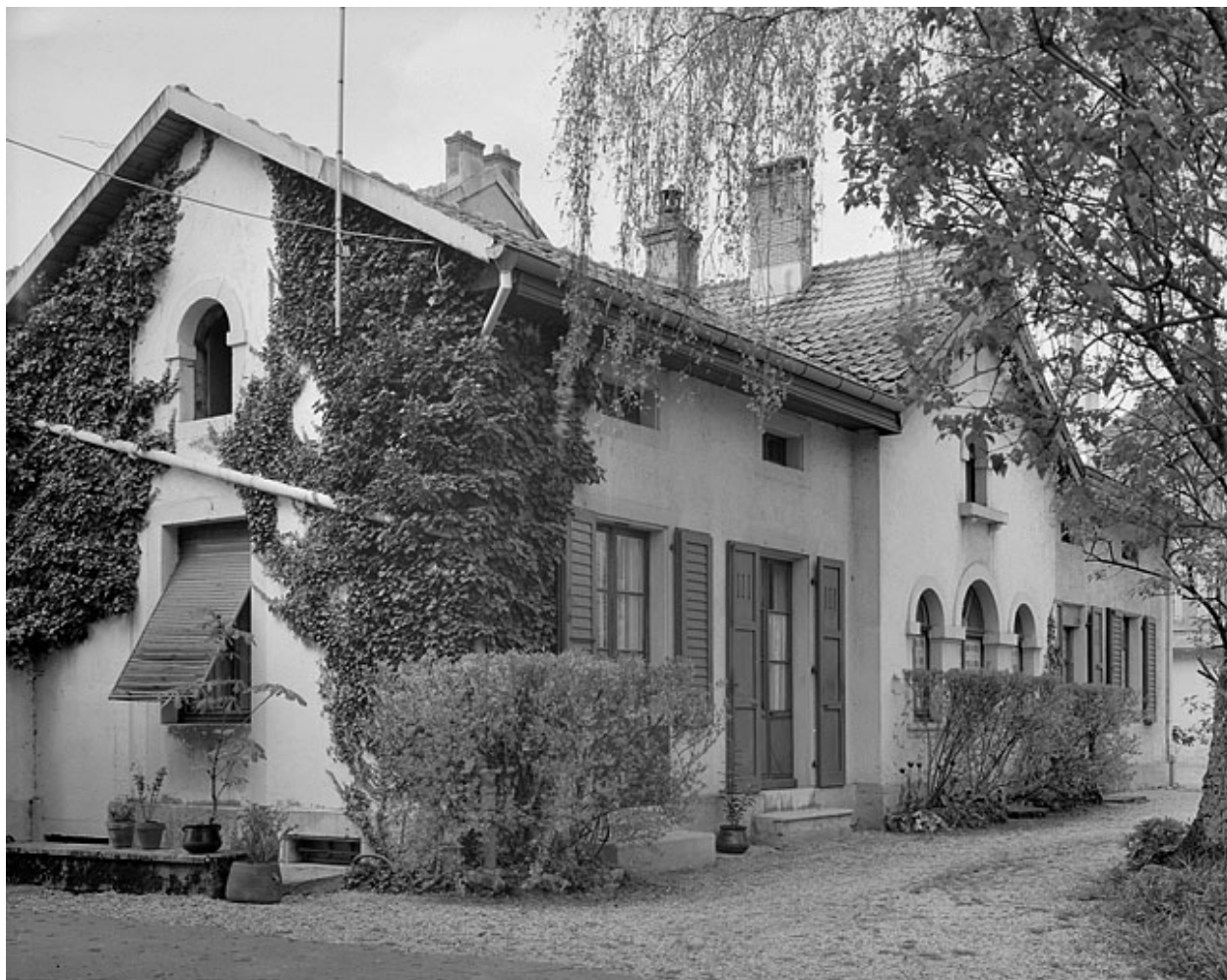
Anciennes écuries. Façades sud et est.
