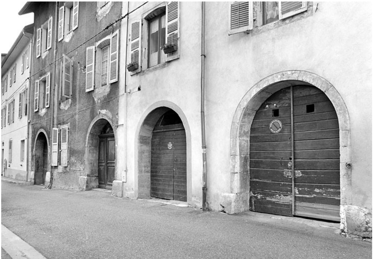
Maison au n° 30 : baies du rez-de-chaussée.
