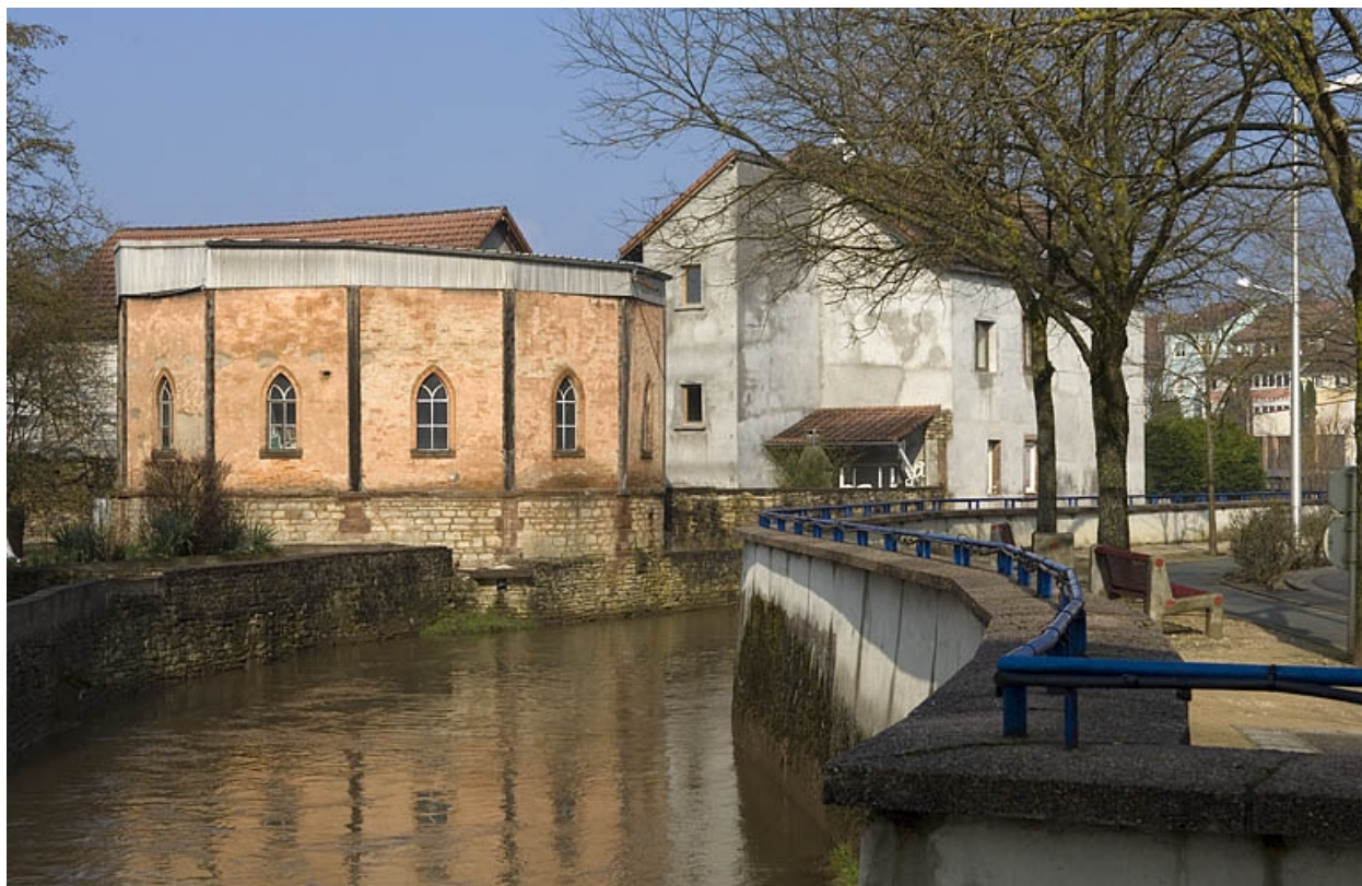
Vue d'ensemble en aval de la Lizaine.
