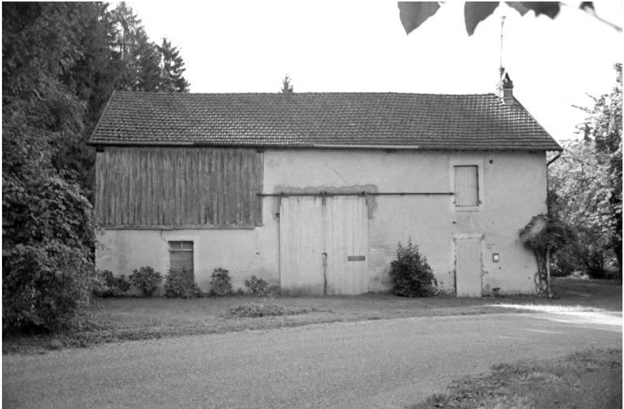
Façade antérieure du logement de contremaître (D).
