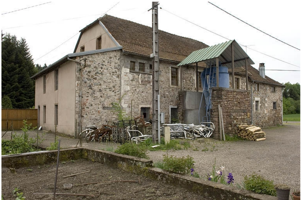
Façade nord de l'atelier de filature.
