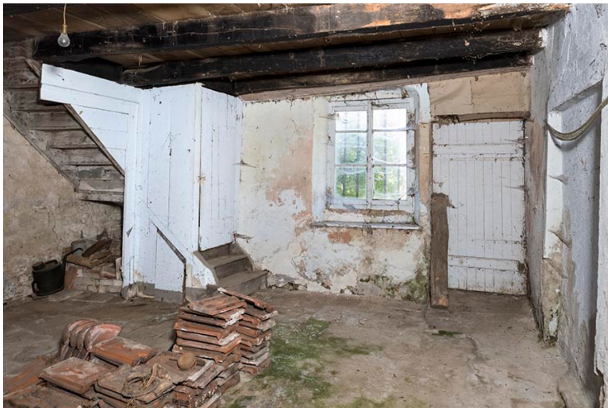
Intérieur : la cuisine en direction de l'entrée.
