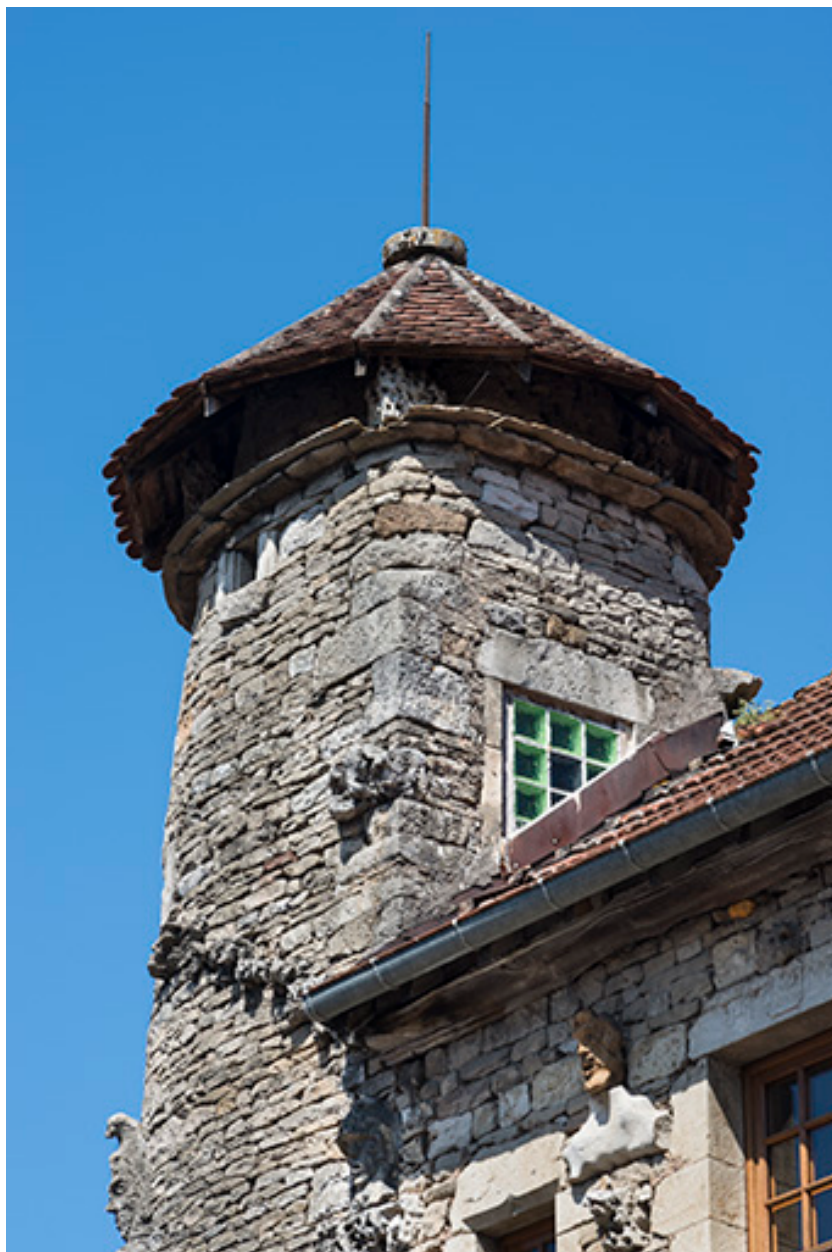
Dernier niveau et couverture de la tourelle.
