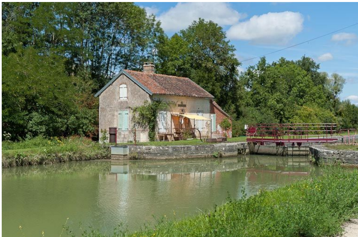
Vue du site d'écluse depuis l'amont.
