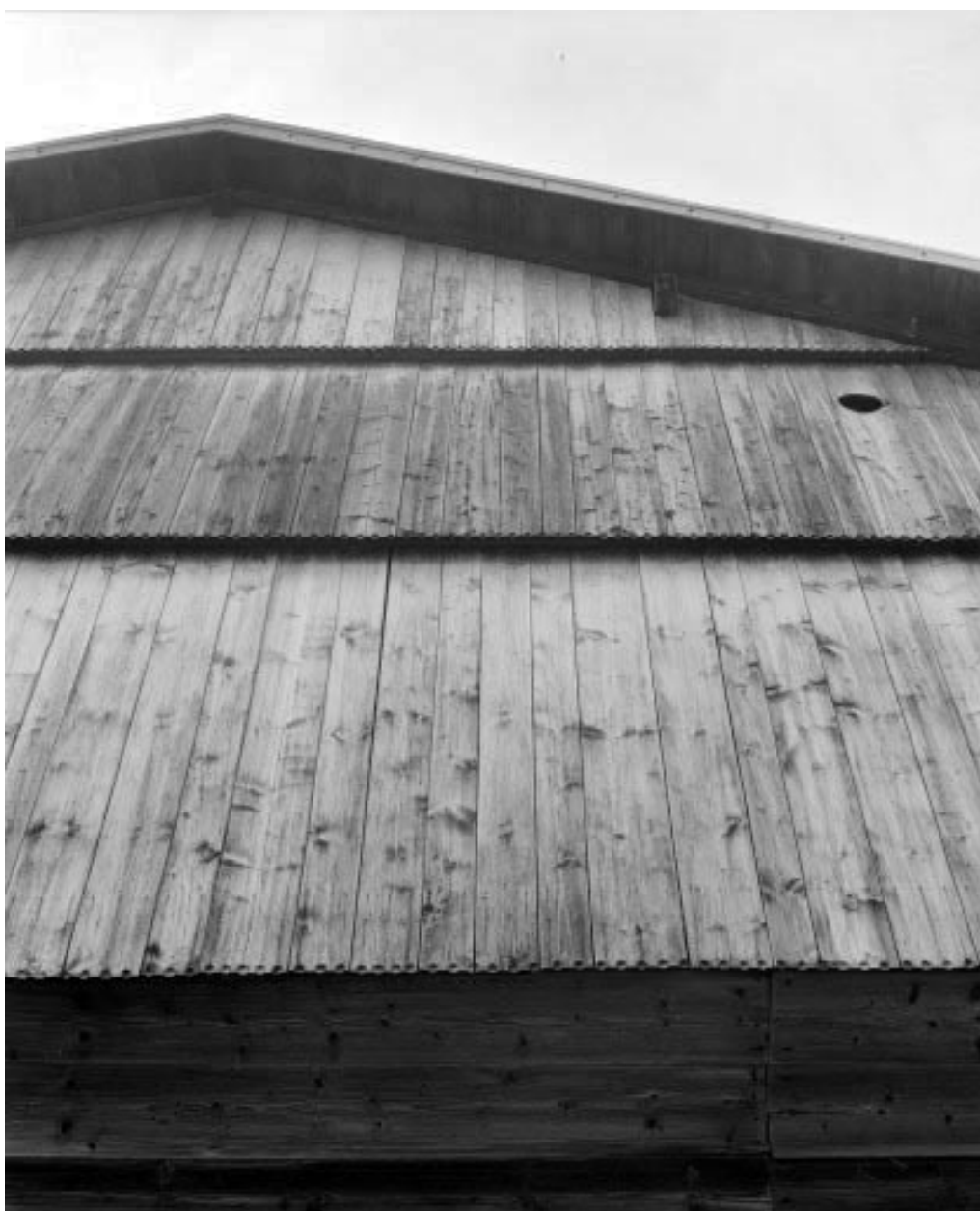
Les Fins : 2e ferme située au lieu-dit Le Bas de la Chaux., "lambrechure" de la façade antérieure.
