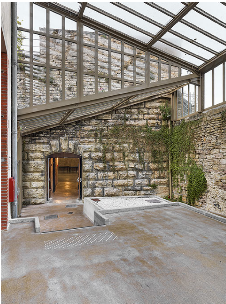
Détail de la maçonnerie et porte d'entrée.
