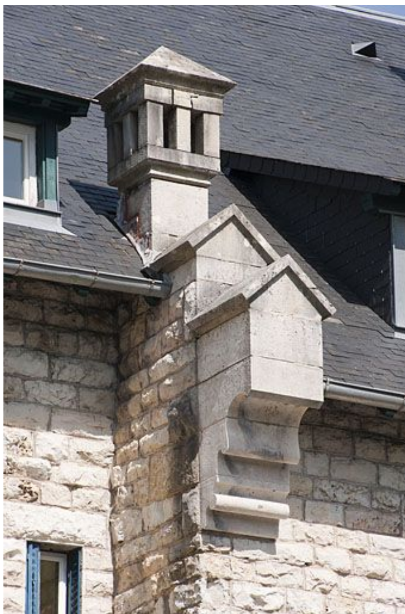
Façade antérieure. Détail d'une console.
