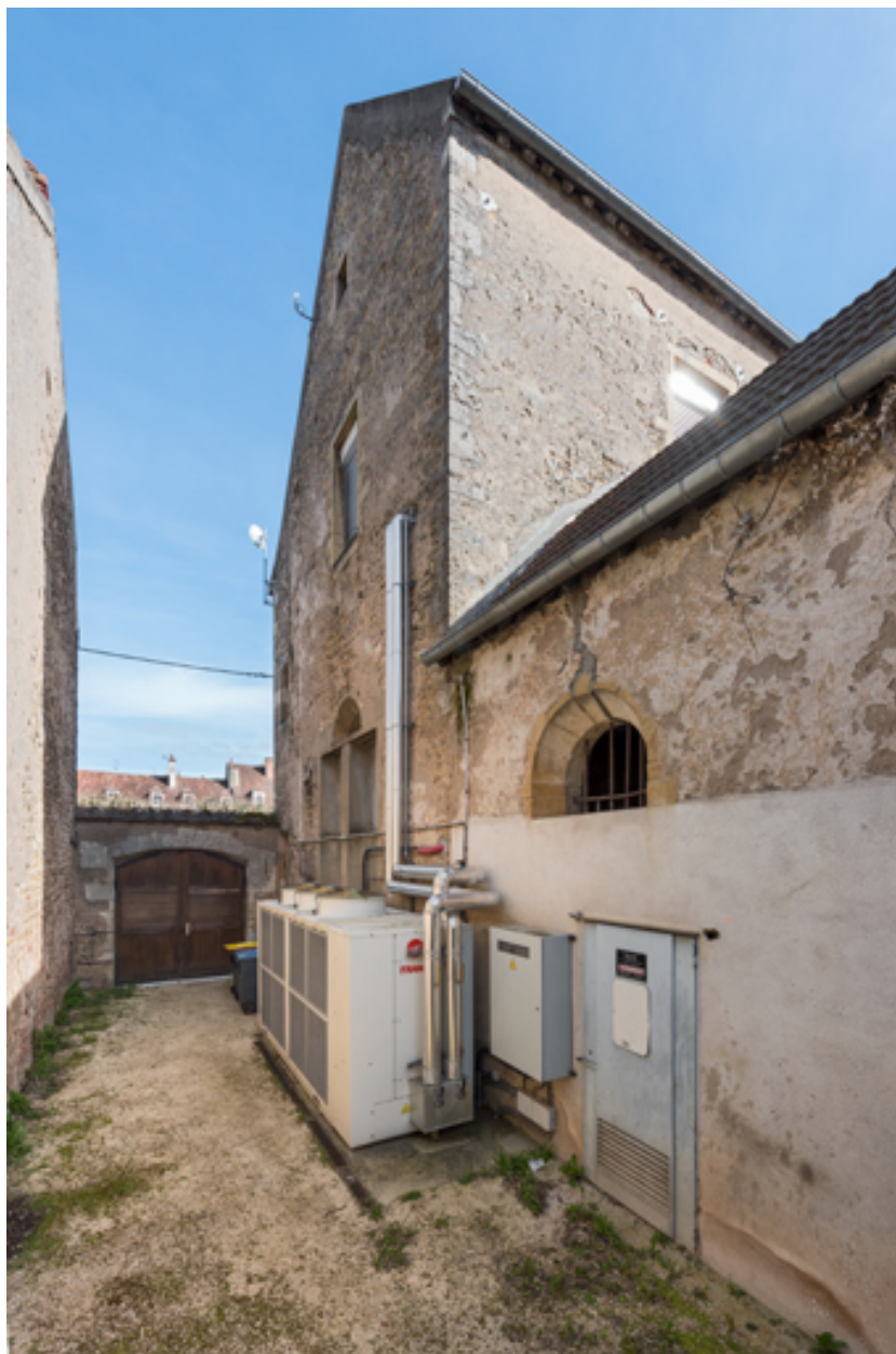
Façade postérieure, vue en enfilade.
