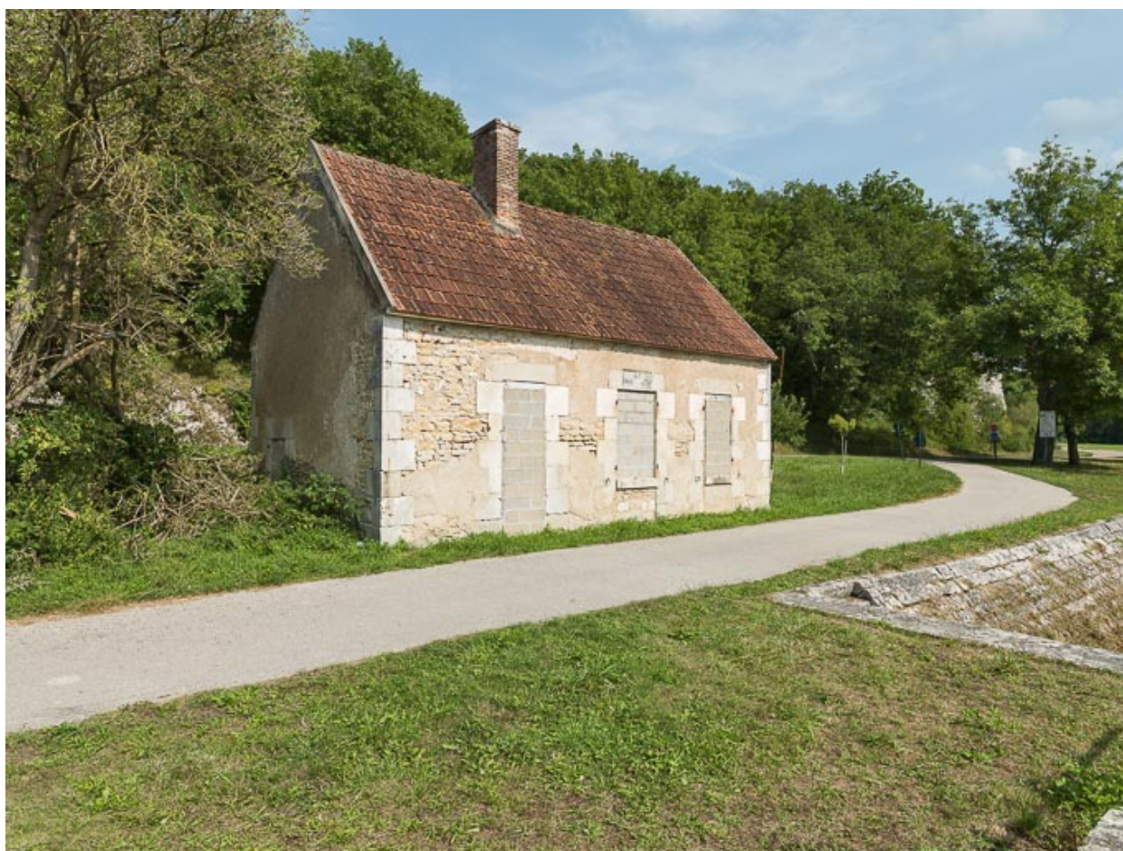
Vue de la maison éclusière.
