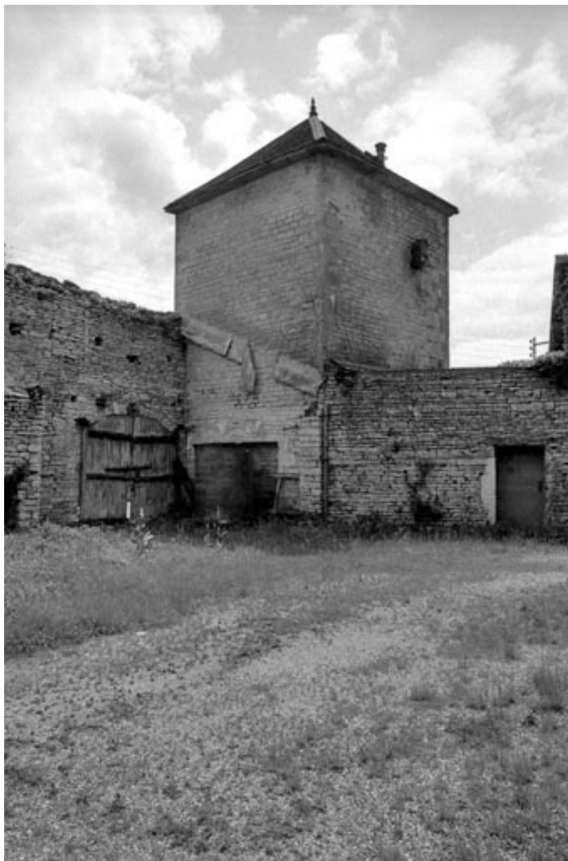
Mur d'enclos de la cour.
