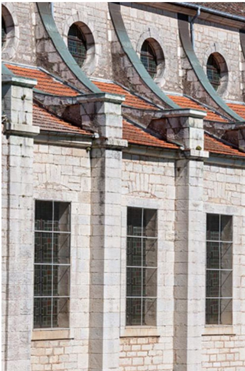
Détail de la façade sud
