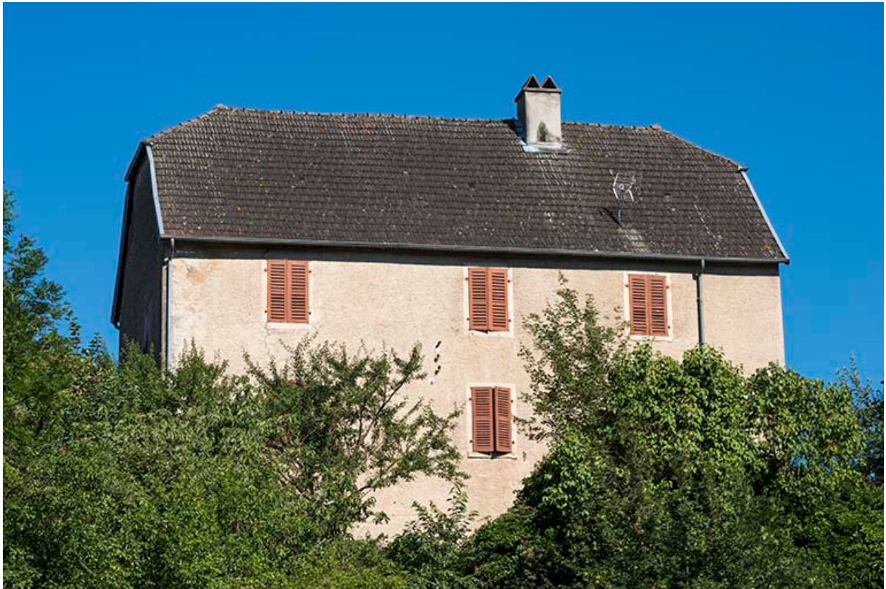
Etages supérieurs de la façade postérieure.
