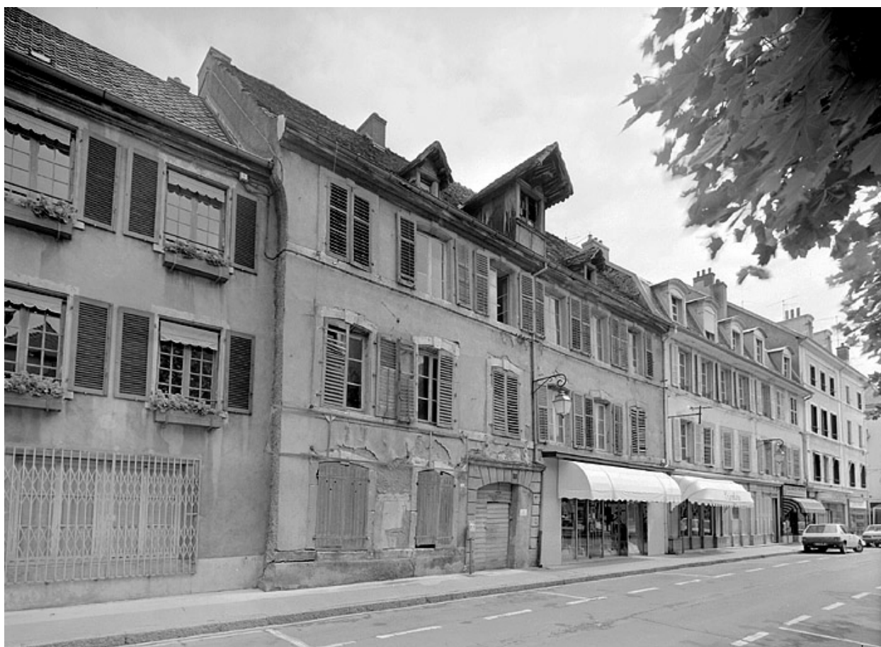
Façade principale sur la place Dorian.
