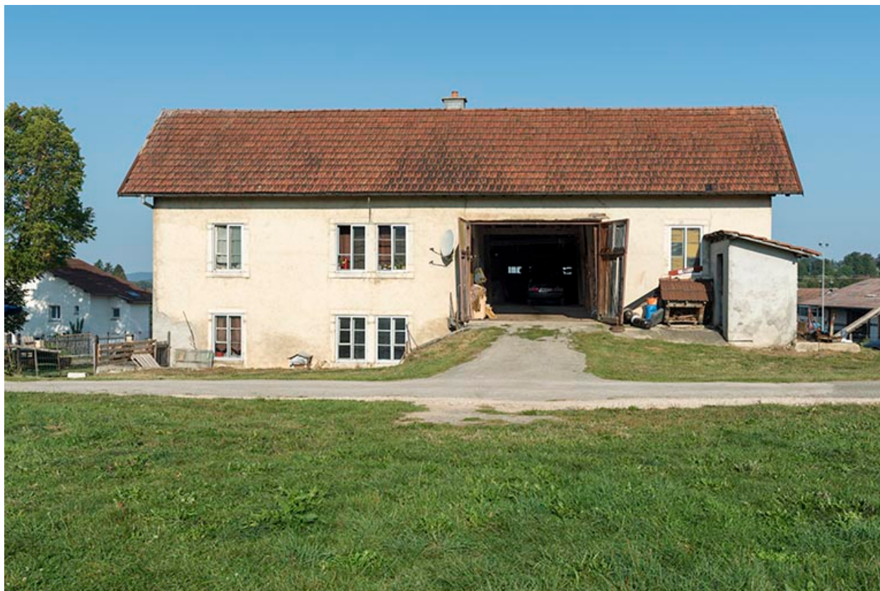
Façade latérale droite.
