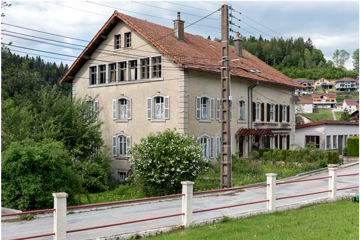
Maison : façades antérieure et latérale gauche.
