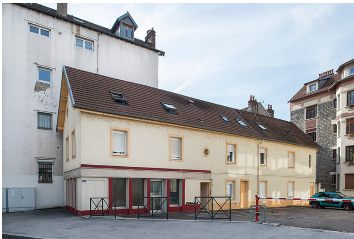
Façade nord de l'atelier.
