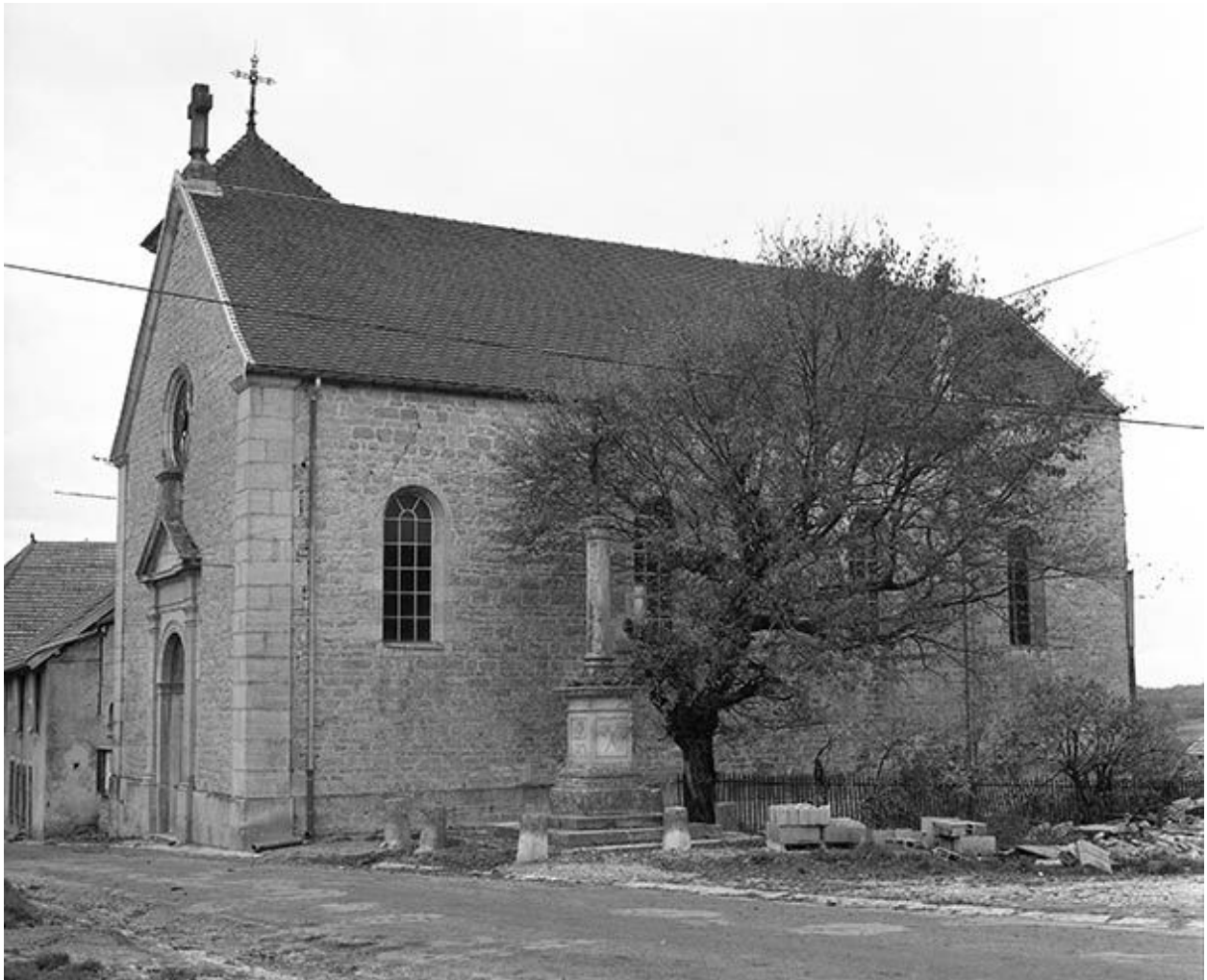
Façade antérieure et face latérale droite.
