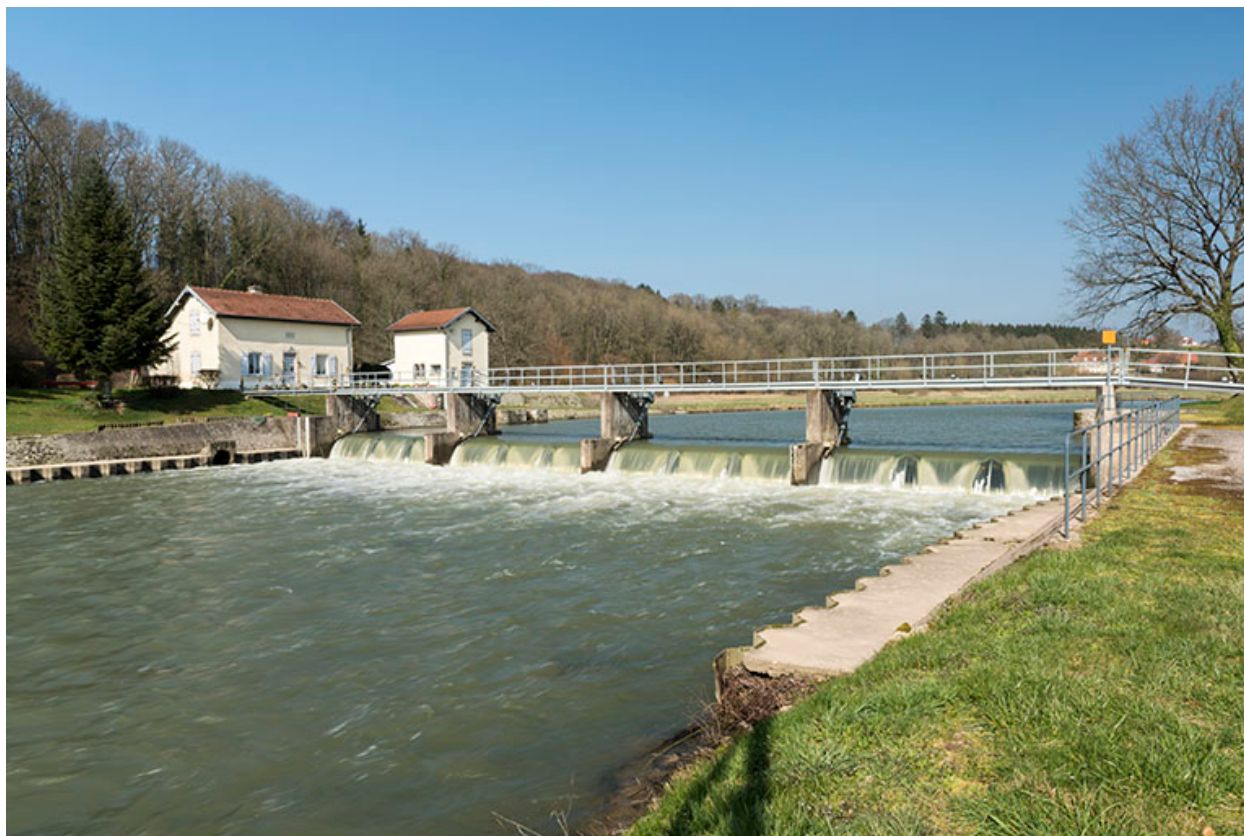
Le site du barrage mobile, vue d'ensemble.
