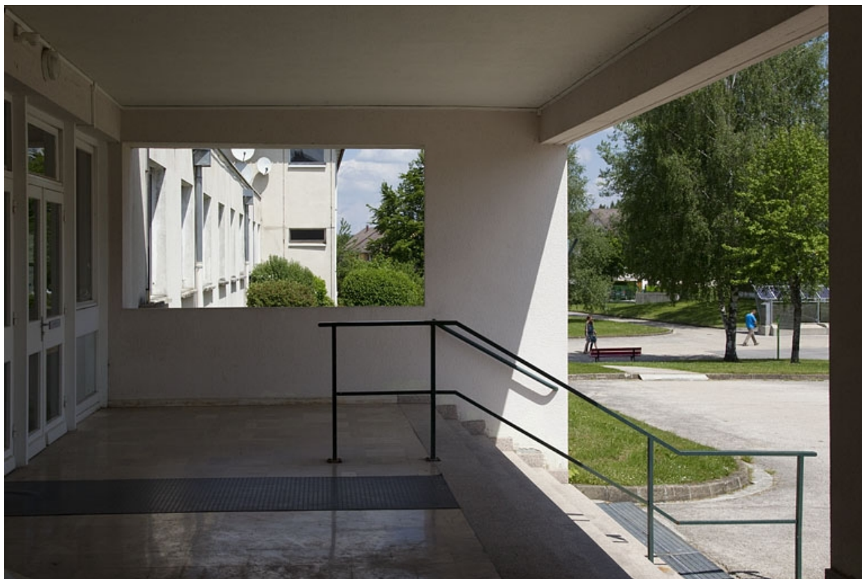
Bâtiment de l'administration : entrée couverte.
