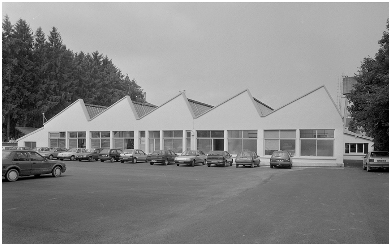
Atelier de fabrication depuis l'est.
