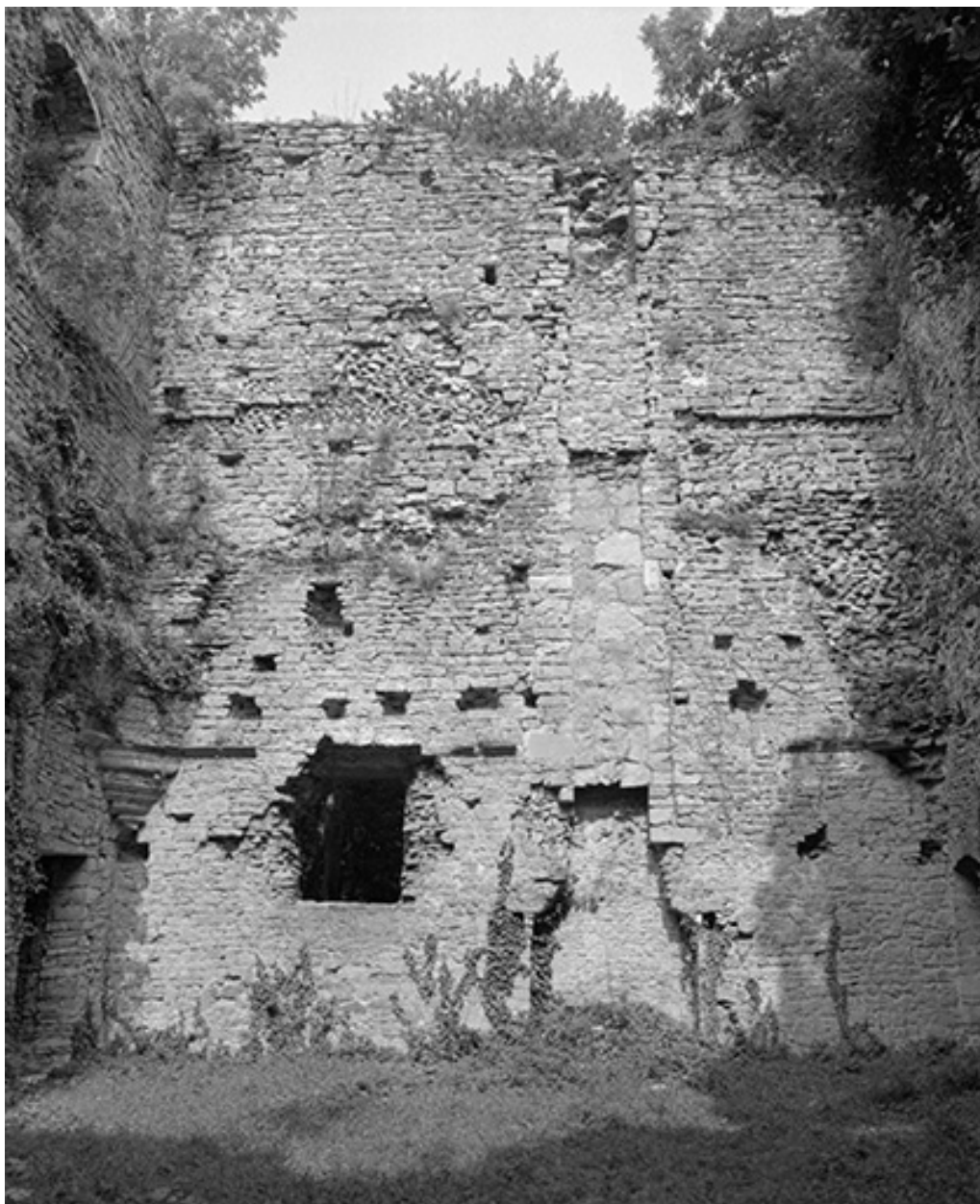
Le donjon, vue intérieure.
